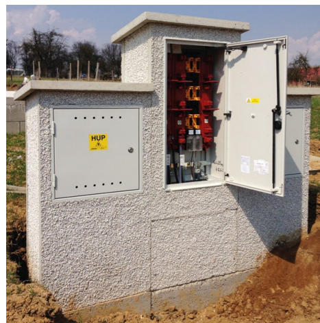
Elektroměrový pilíř s plechovými dvířky a elektroměrovou deskou 45 × 45 cm
