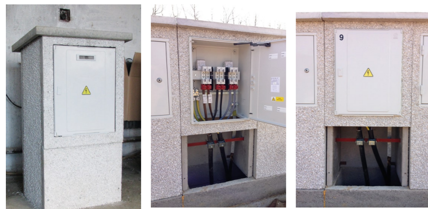
Pilíře SS s demontovanou spodní čelní deskou
