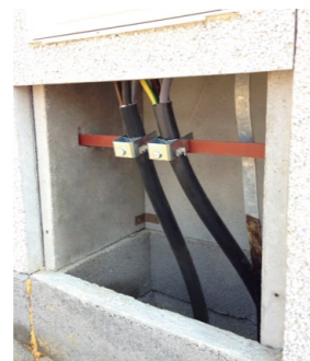
Detail kotvení příchytka SONAP
