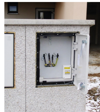
Elektroměrový pilíř – elektroměrová skříň DCK Holoubkov
