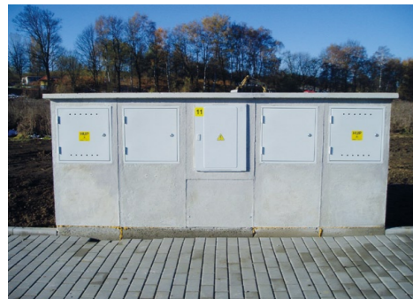
SESTAVA SKŘÍŇÍ PLYN ELEKTRO PE5 E.ON
