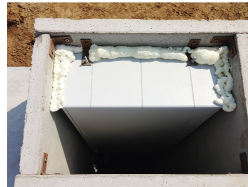
Kotvení plastové skříňe DCK Holoubkov
