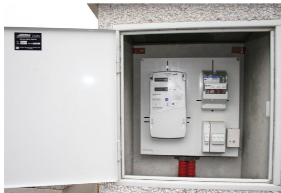
Elektroměrový pilíř s plechovými dvířky a elektroměrovou deskou 45 × 45 cm
