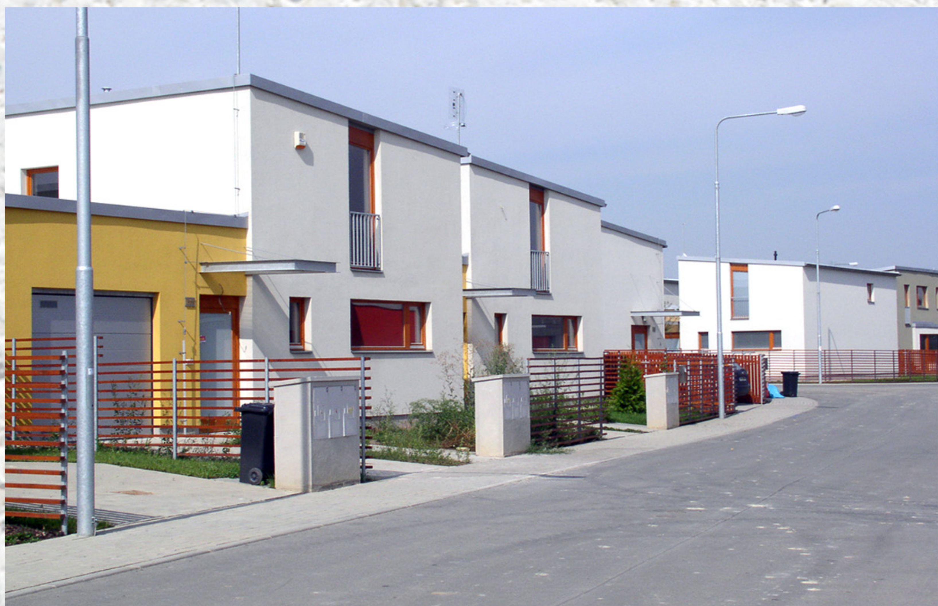
energetický pilíř s využitím plastových skříní DCK Holoubkov
