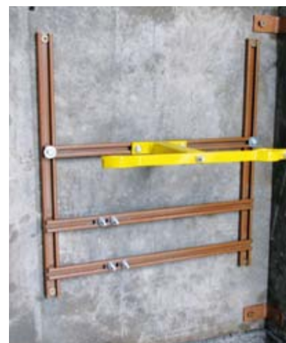
Osazení instalačním rámem
