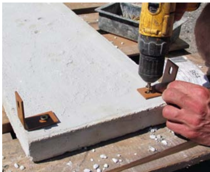
Kotvení montážních úhelníků
