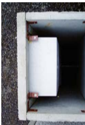
Kotvení plastové skříně
