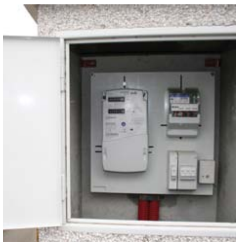
Osazení elektroměrné desky
